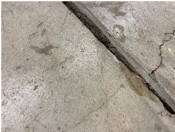
Liikuntasauomoissa on ohut metallikaista ja toiminnasta syntynyttä roskaa
