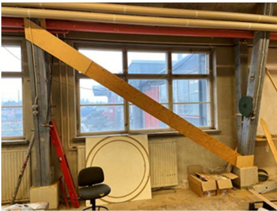
Halkeilevia kehiä tuettu hallista
