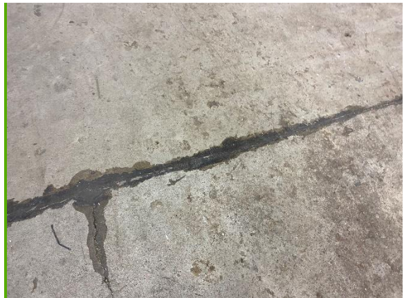
Liikuntasaumaa massattu rakentamisajankohdan jälkeen
