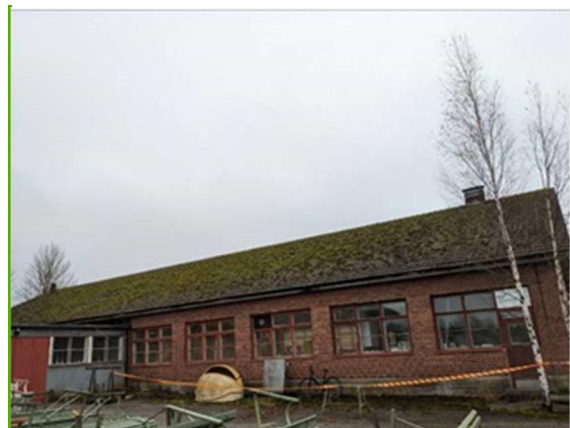
Yleiskuva julkisivusta länteen
