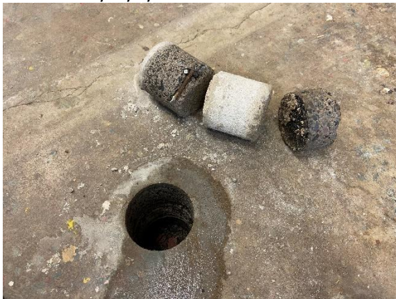
Reuna-alueilla alapohjarakenteessa on lämmöneriste betonilaattojen välissä. Eristeenä on kevytbetonia. Pintalaatassa näkyy ohut taasoite/betonikerros
