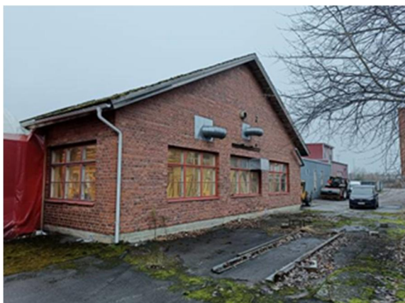
Yleiskuva julkisivusta pohjoispäädyssä
