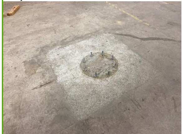
Rakentamisajankohdan jälkeen valettu antura laitejalustalle
