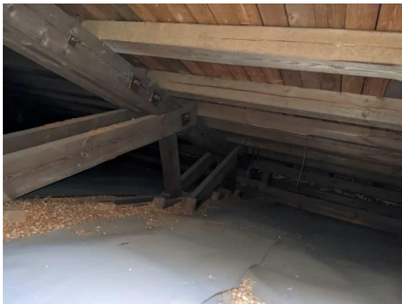
Yleiskuva yläpohjasta räystäään suuntaan
